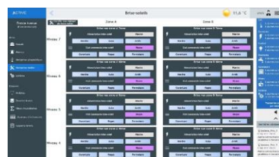
Vue de contrôle des brise-soleils
